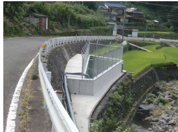
防火水槽新設工事
