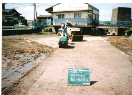
南舟津雨水ポンプ場沈砂池地盤改良工事
