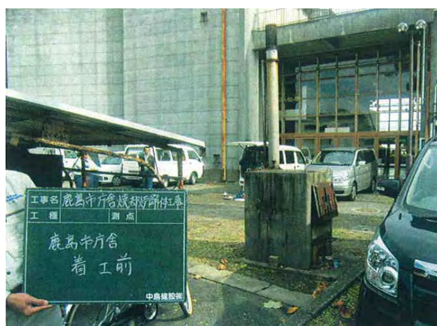
焼却炉解体撤去事業
