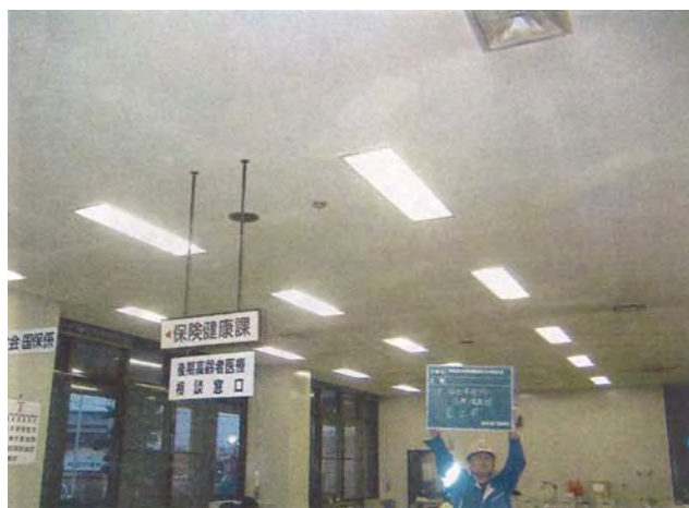
照明設備省エネ改修事業(省エネタイプ蛍光管へ)
