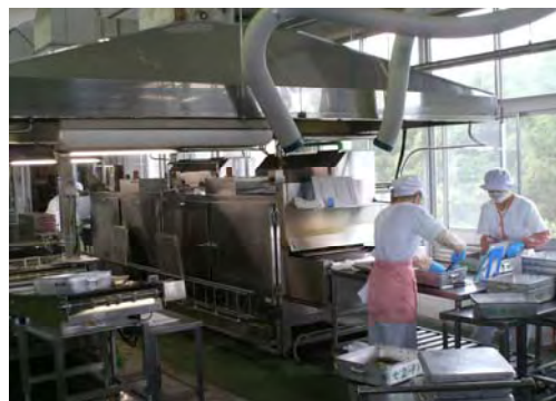
○更新した厨房機器（焼物機）
